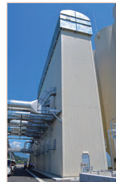
乾燥機設備 (60t x 5 基、20t x 1 基 : 合計 320t)
