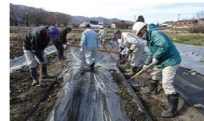
水路をつくる様子
